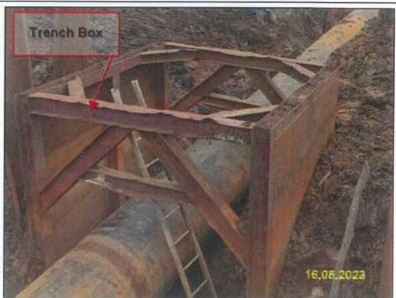
รูปที่ 2-11 การติดตั้ง Sheet Pile หรือ Trench Box เพื่อป้องกันการพังทลายของดิน
