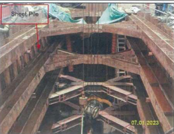
รูปที่ 2-11 การติดตั้ง Sheet Pile หรือ Trench Box เพื่อป้องกันการพังทลายของดิน
