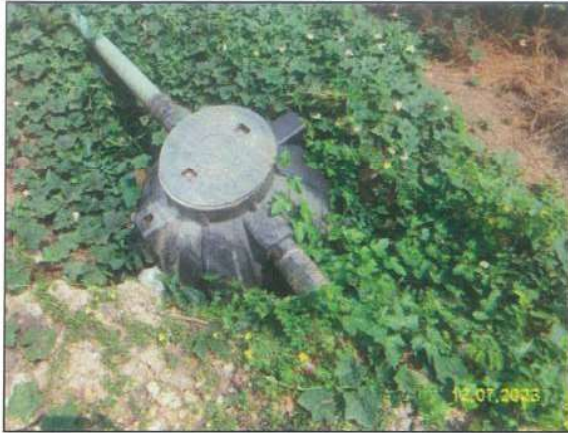
รูปที่ 2-16 การติดตั้งระบบบำบัดน้ำเสียสำเร็จรูปที่ได้มาตรฐาน / บ่อพักน้ำทิ้งโครงการบริเวณสำนักงาน ของโครงการ
