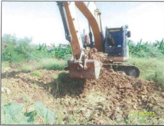
ท) การבודัดพื้นบ่อและผนังบ่อทิ้งโคลนโซเดียมเบนโทไนท์ (ช่วงเตรียมบ่อ)
