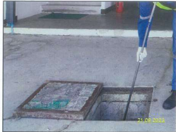
รูปที่ 2-16 การติดตั้งระบบบำบัดน้ำเสียสำเร็จรูปที่ได้มาตรฐาน / บ่อพักน้ำทิ้งโครงการบริเวณสำนักงาน ของโครงการ
