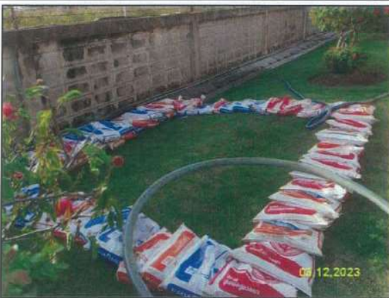
การล้อมกระสอบทรายเพื่อจำกัดบริเวณ โคลนโซเดียมเบนโทไนท์ที่รั่วไหล
