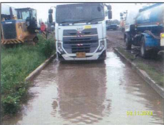
รูปที่ 2-8 การจัดทำพื้นที่ล้างล้อพร้อมทั้งล้างทำความสะอาดเศษดิน และเศษโคลนที่ติดกับล้อรถ ก่อนออกจากพื้นที่เก็บกองท่อ (Stock Yard) และพื้นที่ก่อสร้าง
