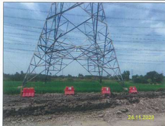
ก) การป้องกันฐานของเสาส่งไฟฟ้าแรงสูง
