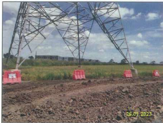
ก) การป้องกันฐานของเสาส่งไฟฟ้าแรงสูง
