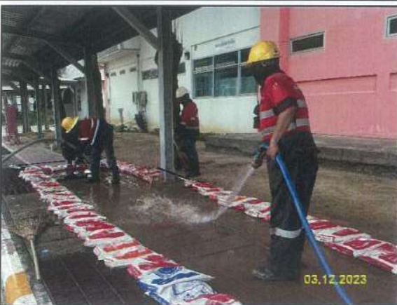
ญ) ล้างทำความสะอาดโคลนโซเดียมเบนโทไนท์ที่รั่วไหลขึ้นในบริเวณพื้นที่ใกล้เคียง
