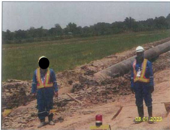
ก) การสวมใส่อุปกรณ์ป้องกันอันตรายส่วนบุคคลผู้เชี่ยวชาญในการตรวจสอบรอยเชื่อมด้วยวิธีทดสอบที่ไม่ทำลายสภาพ และ Film Badge
