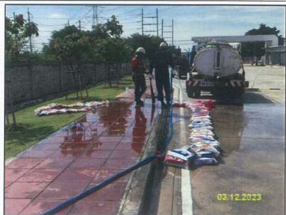
ญ) ล้างทำความสะอาดโคลนโซเดียมเบนโทไนท์ที่รั่วไหลขึ้นในบริเวณพื้นที่ใกล้เคียง
