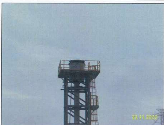
ติดตั้งอุปกรณ์ควบคุมเสียง (Silencer) ที่ปล่องระบายก๊าซฯ (Vent Stack)
